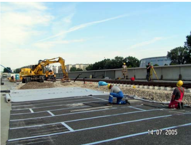
Abb. 3: Verlegen der DAMTEC® KRAIBURG USM
