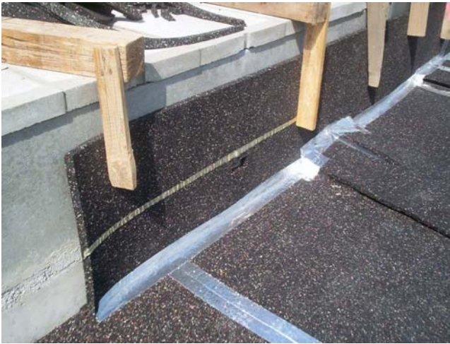
Abb. 5: Einbau in den Randbereichen
