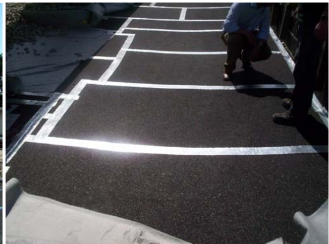
Abb. 4: Verkleben der Stöße mit Spezialklebeband
