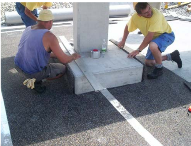
Abb. 9: Ausschneiden in Stützenbereichen
