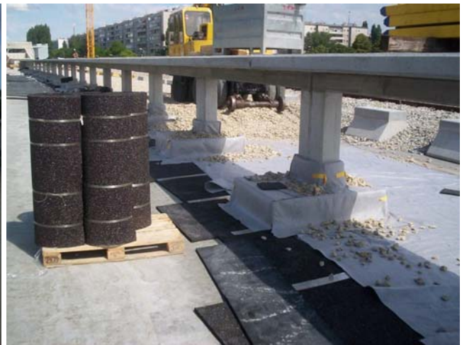
Abb. 2: Anlieferung der Rollenware DAMTEC® KRAIBURG USM auf Palette
