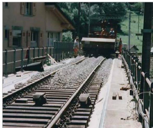
Bild 13: Verlegen der USM
