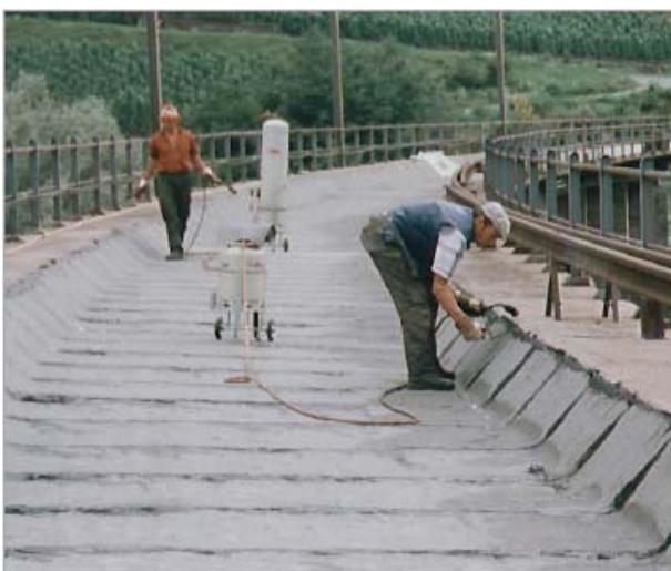
Bild 6: Verschweißen der wasserdichten Abdeckungsschicht
