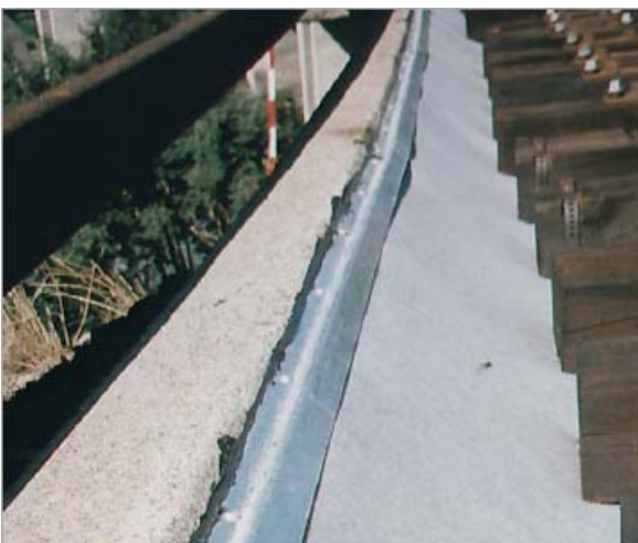
Bild 12: Vlies & Abdeckprofil als Schutz vor Verschmutzung & Schotterabrieb
