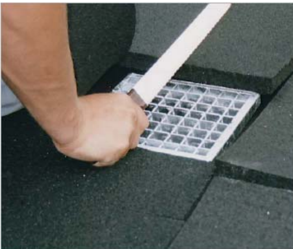
Bild 10: Ausschneiden der USM für Entwässerungsbereiche
