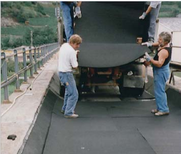
Bild 8: Verlegen der USM
