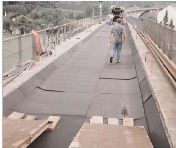
Bild 9: Verlegen der USM
