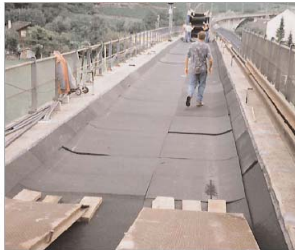
Ill. 9 : Pose du tapis sous ballast
