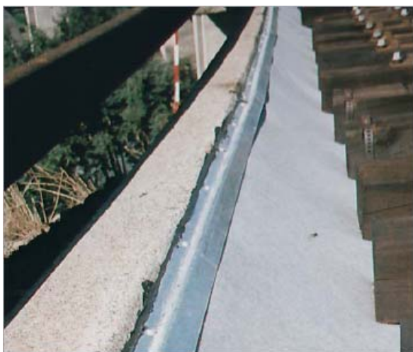
Ill. 12 : Non-tissé et profilé de recouvrement, protection contre les saletés et l'usure par abrasion de par le ballast
