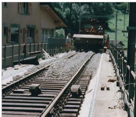
Ill. 13 : Pose du tapis sous ballast
