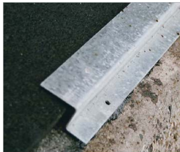
Ill. 11 : Profilé de recouvrement ST-37 galvanisé
