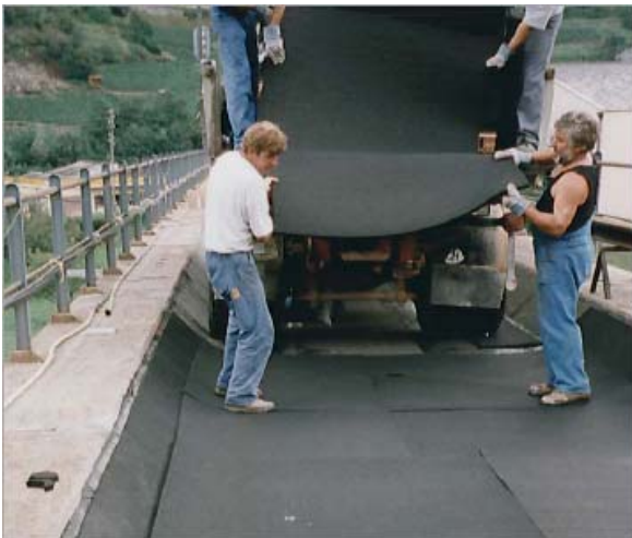
Ill. 8 : Pose du tapis sous ballast
