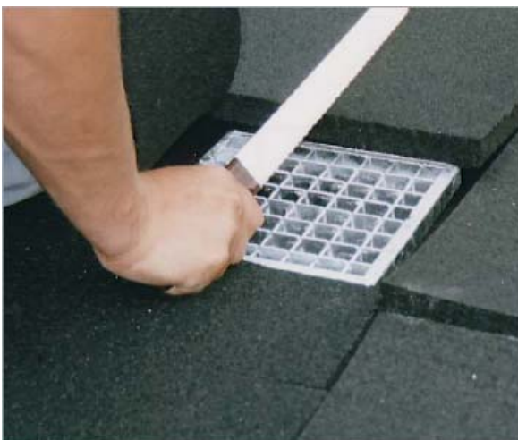
Ill. 10 : Découpe du tapis sous ballast pour les zones de drainage
