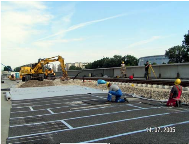
Fig. 3: Laying the DAMTEC ® KRAIBURG USM Sub Ballast Mat
